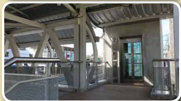
ภาพถ่ายสะพานลอยข้ามทางลดระดับบริเวณแยก ถนนสุขุมวิท - ถนนพัทยากลาง จ.ชลบุรี
