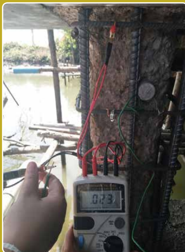
การติดตั้งโลหะกันกร่อน (Sacrificial Anode) ในงานซ่อมแซมตอม่อสะพาน จ.สมุทรสาคร
