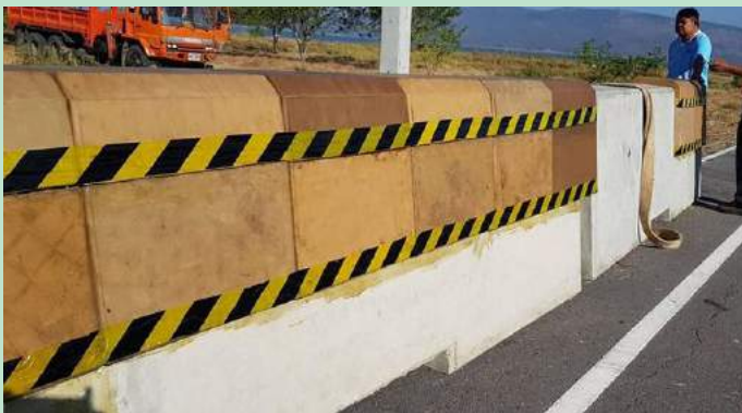
แผ่นยางธรรมชาติครอบกำแพงคอนกรีต Rubber Fender Barrier (RFB)
