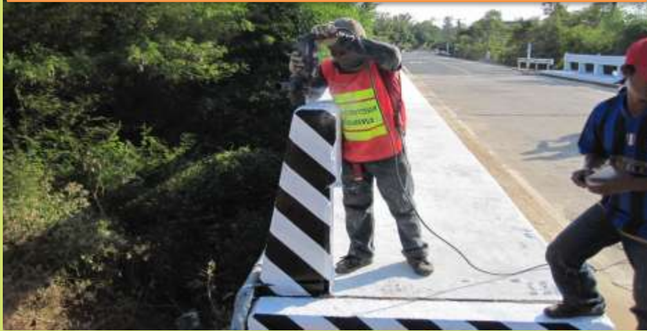
ติดเป้าสะท้อนแสงราวสะพาน ทุก 10 ม.
